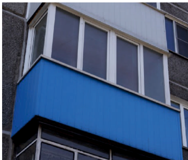
Верх - ПВХ, низ - металлосайдинг
