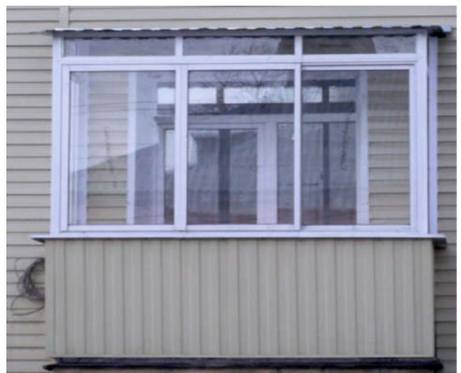
Верх - алюминий, низ - металлосайдинг
