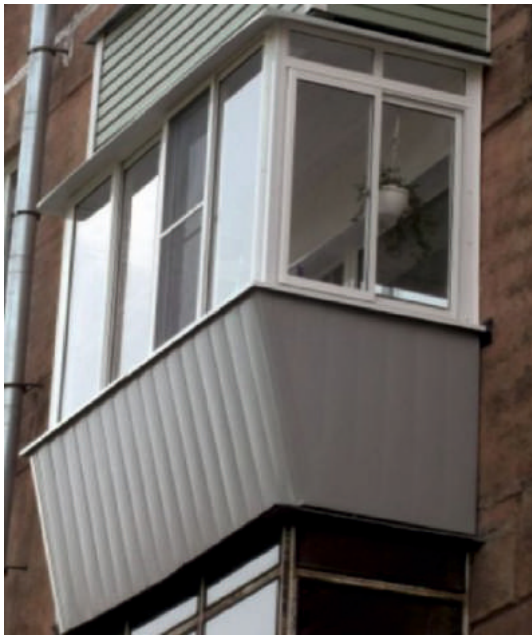
Верх - алюминий, низ - металлосайдинг
