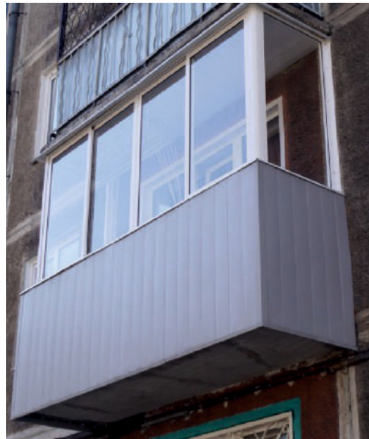
Верх - алюминий, низ - металлосайдинг
